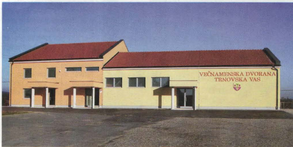
Ob občinskem prazniku so odprli večnamensko dvorano.
